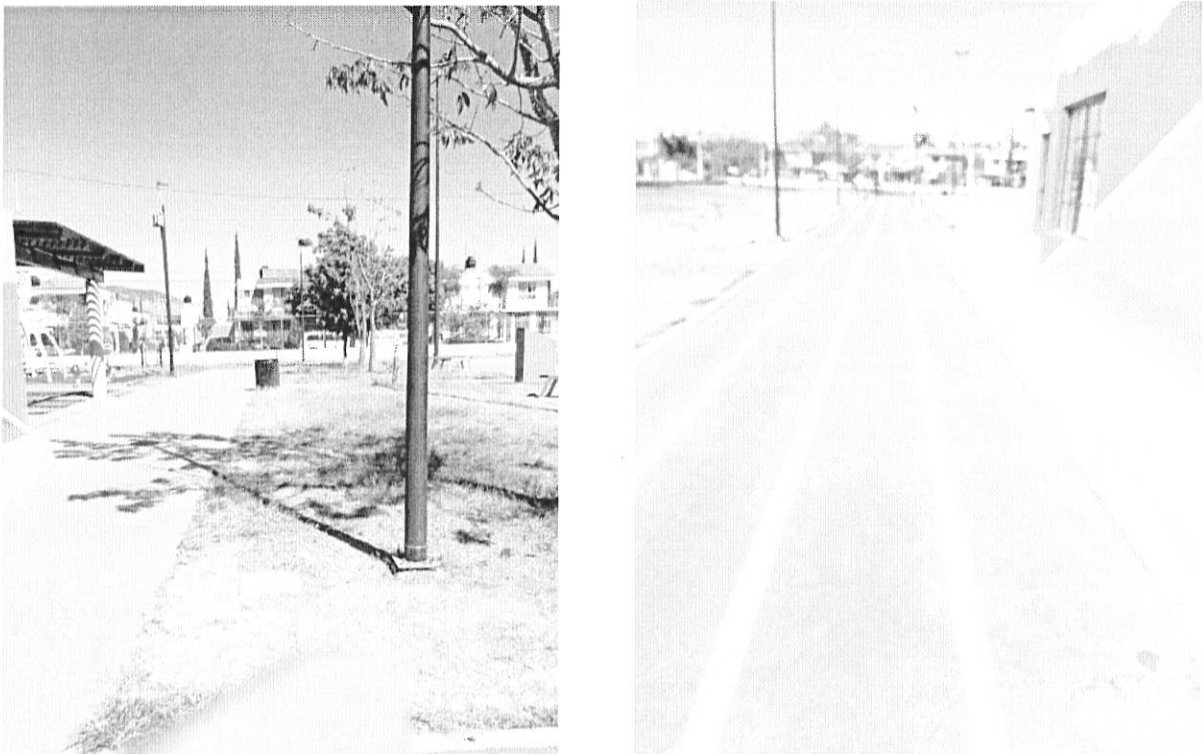
Se realizó limpieza general.
